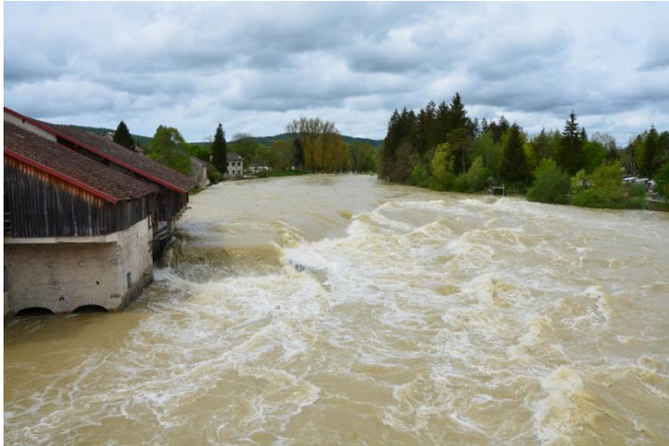
Crue de l'Ain à Pont de Poitte le 02 mai 2015.
