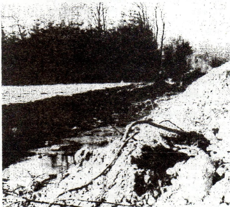
La Sirène, après les travaux, à Uxelles.
